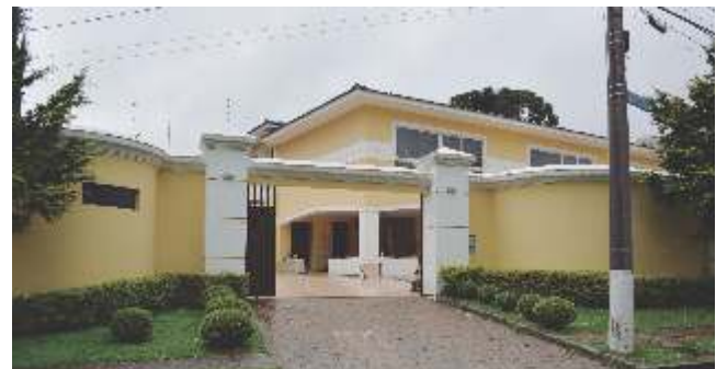
Fachada da nova Sede do CRF-PR.
